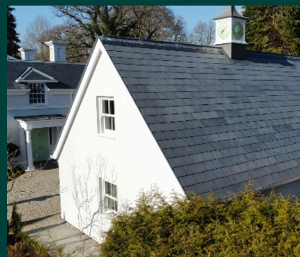
Solar Slate Edge To Edge Installation
